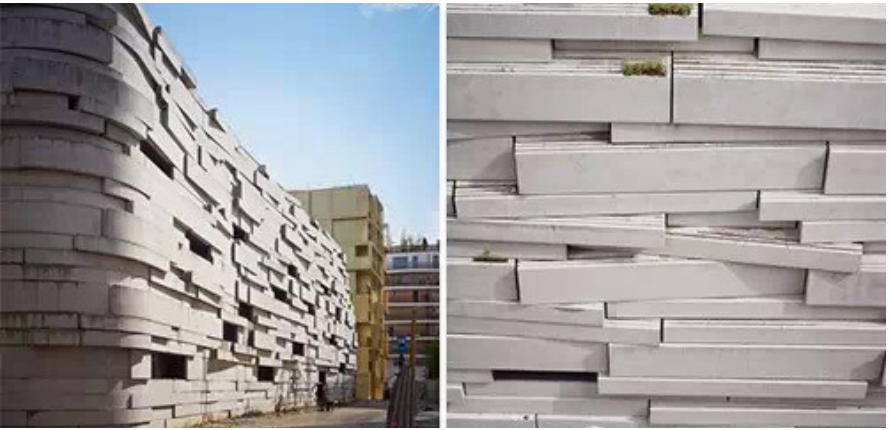
生命墙由预制混凝土砖砌筑
